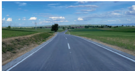
Neu sanierte Sulzer Straße
