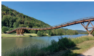
Holzbrücke Tatzlwurm bei Essing
